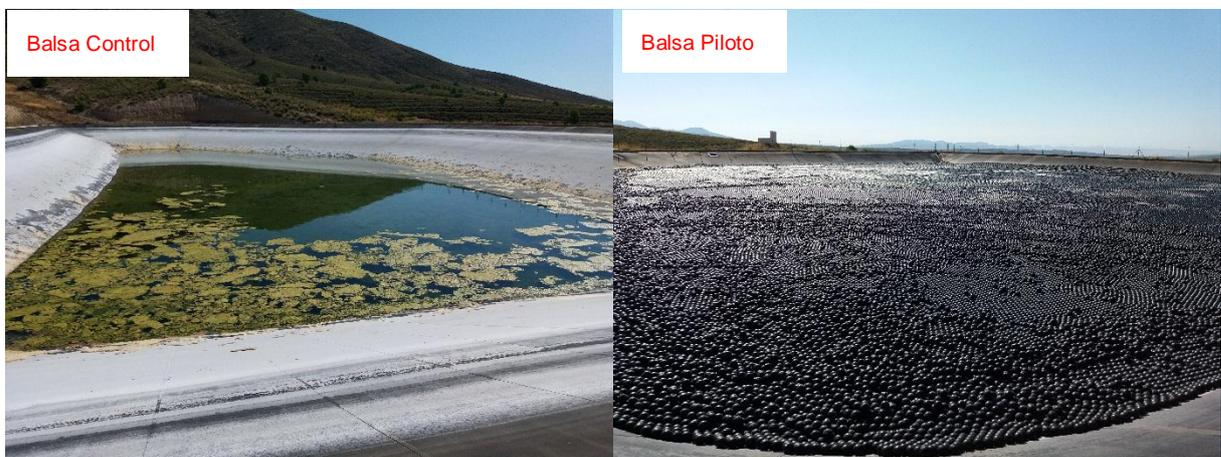
Figura 3 Detalle de la Balsa Control y la Balsa Piloto ya con el Panal Flotante instalado.
